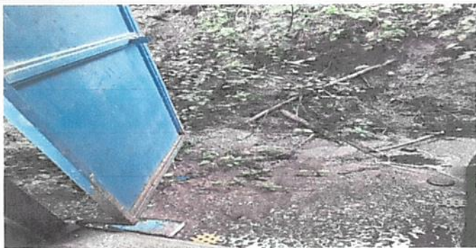
FOTO 3: Saturación de lodo en la puerta
